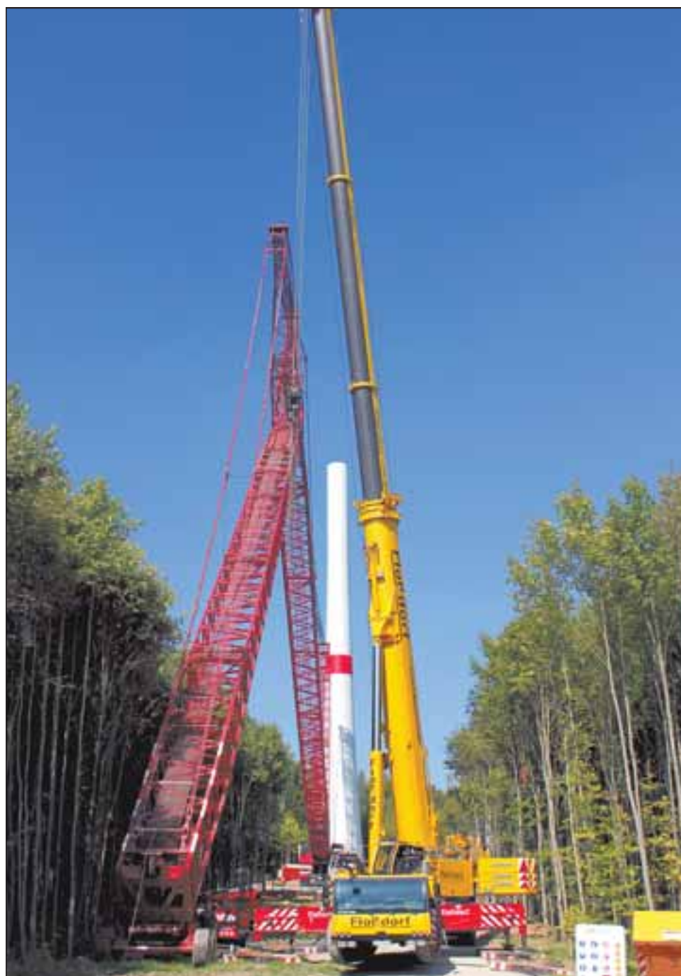
An WKA 4 wurde gestern ein 600 Tonnen schwerer Kran aufgestellt. Demnächst werden die Stahlsegmente montiert. Foto: T. Radan
